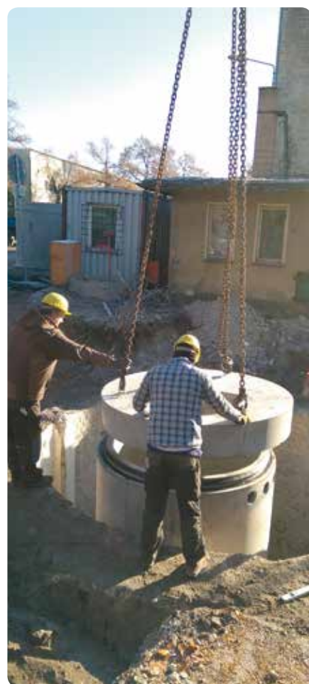
Ein scharfes Auge ist nötig, damit Schachtelemente und Dichtungen übereinander passen.
