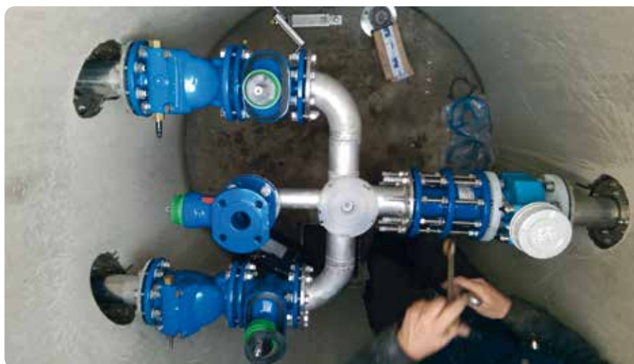
Die Armaturen- und Rohrleitungselemente werden montiert.
