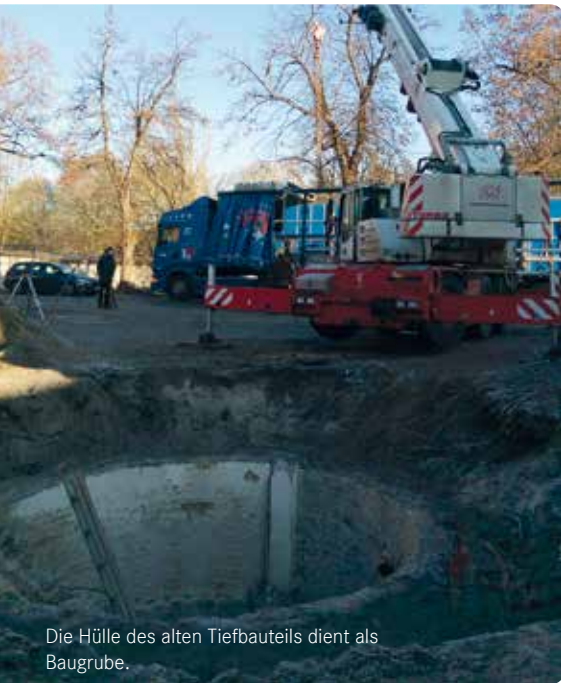
Mit dem Kran werden die einzelnen Schachtelemente in die Baugrube gesetzt.
