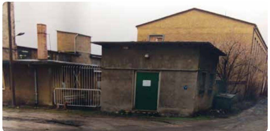
Das alte Pumpwerk in der Potsdamer Straße.
